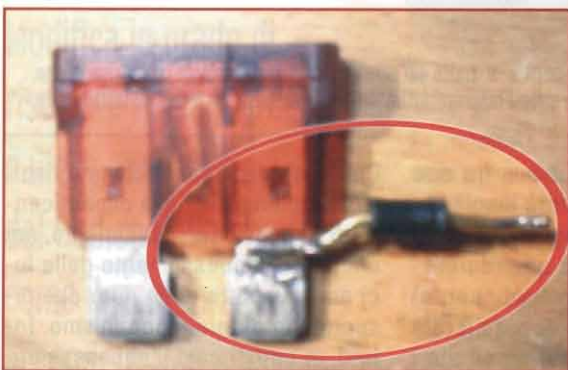
foto 2 Esempio di prelievo corrente da un fusibile. In questo caso essendo il fusibile della sezione motore, il prelievo avviene già con D6.
